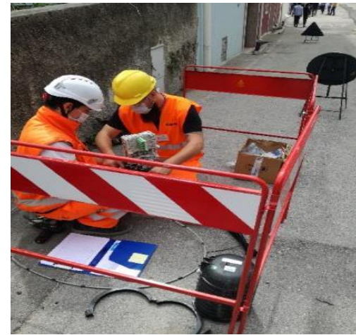
Giunzione del cavo in fibra ottica dalla strada all'abitazione
