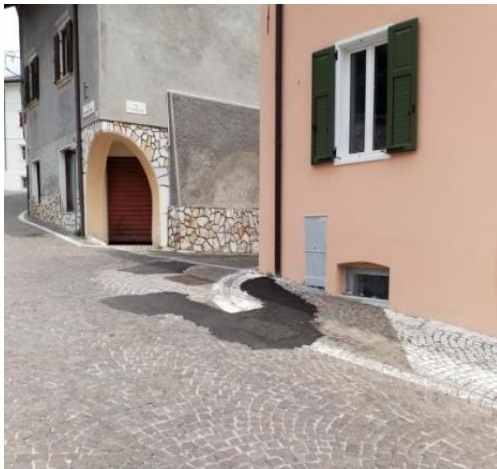
Esempio di riutilizzo di infrastrutture esistenti
