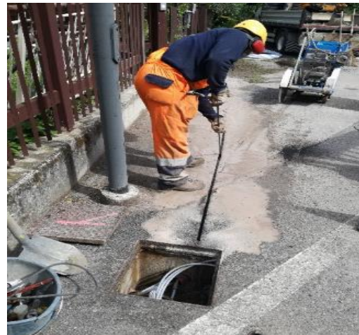
Esempio di nuovo scavo in tecnica di microtrincea
